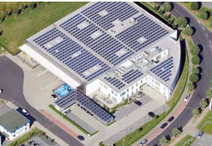
Die Photovoltaik-Anlage auf dem Dach produziert bis zu 240.000 kWh Strom jährlich. Der innovative Firmensitz entstand bereits 2013 im Plusenergie-Standard – wissenschaftlich begleitet von der Ostfalia Hochschule.
